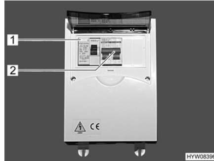
Kuva 79 230 V:n sulakerasia ja johdinsuojakytkin sekä FI-kytkin
